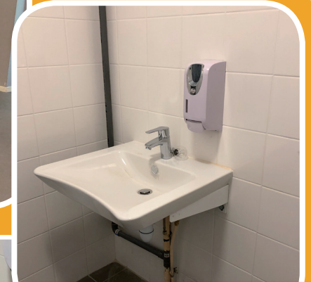
Mise en accessibilité des sanitaires des loges du centre culturel
