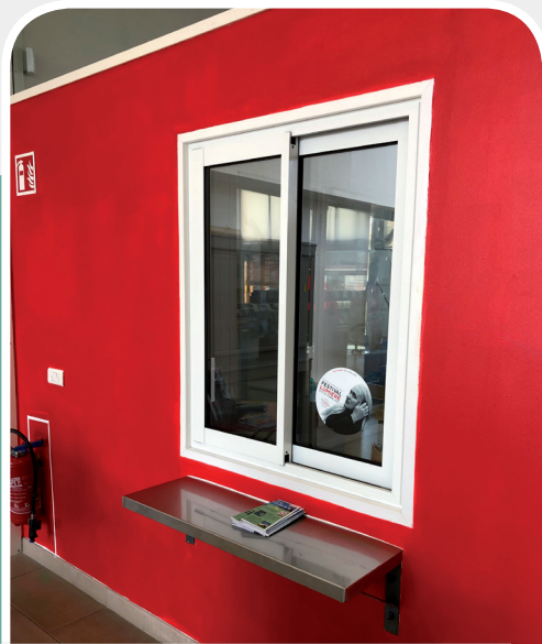
Mise en accessibilité de la billetterie du cinéma
